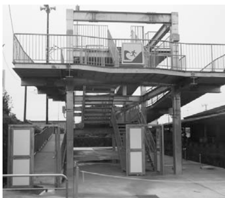
▲津波避難タワー(上堺地区)
